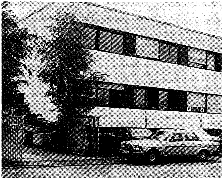
Außen ist nichts zu sehen, doch innerhalb dieser Mauern an der Industriestraße steht eine völlig zerstörte Heißverzinnungsanlage.
