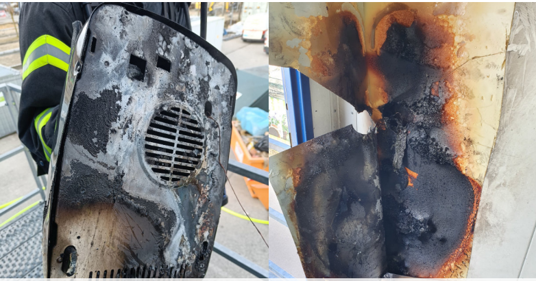
Brand Heizlüfter im Baucontainer | 25.02.
