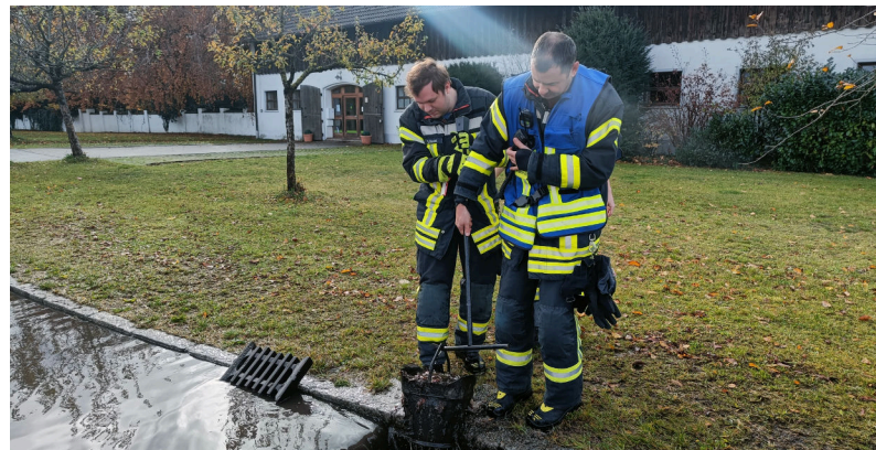
19.11. | Straße überflutet d. verstopften Gulli
